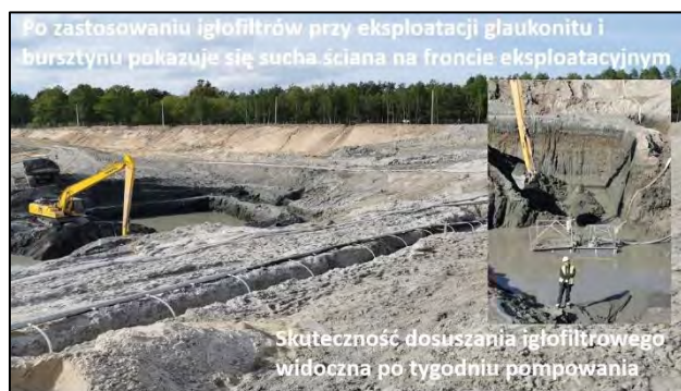
Ryc. 6. Uformowanie się suchego frontu eksploatacyjnego poziomu glaukonitowego.
